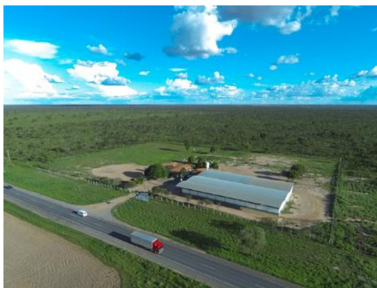
Figura 13- Central Campo Limpo Barreiras
