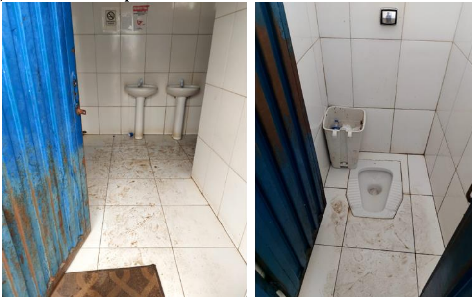
Figura 33 - Sanitário público do centro de abastecimento de Barreiras - CAB.
